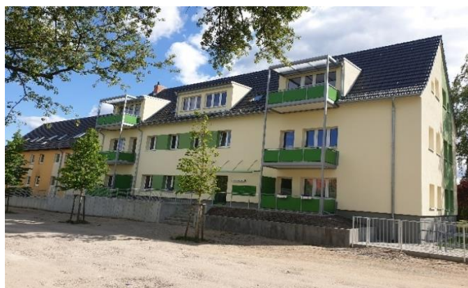
Kommunaler Wohnungsbau Bunzelweg 19 D
