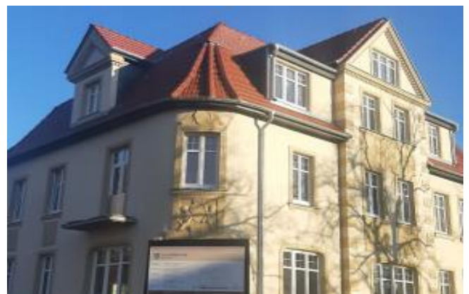
saniertes Haus Goethestraße 35
