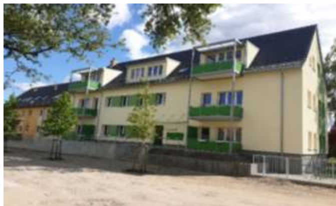
Kommunaler Wohnungsbau Bunzelweg 19 D
