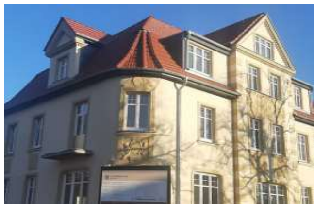
saniertes Haus Goethestraße 35
